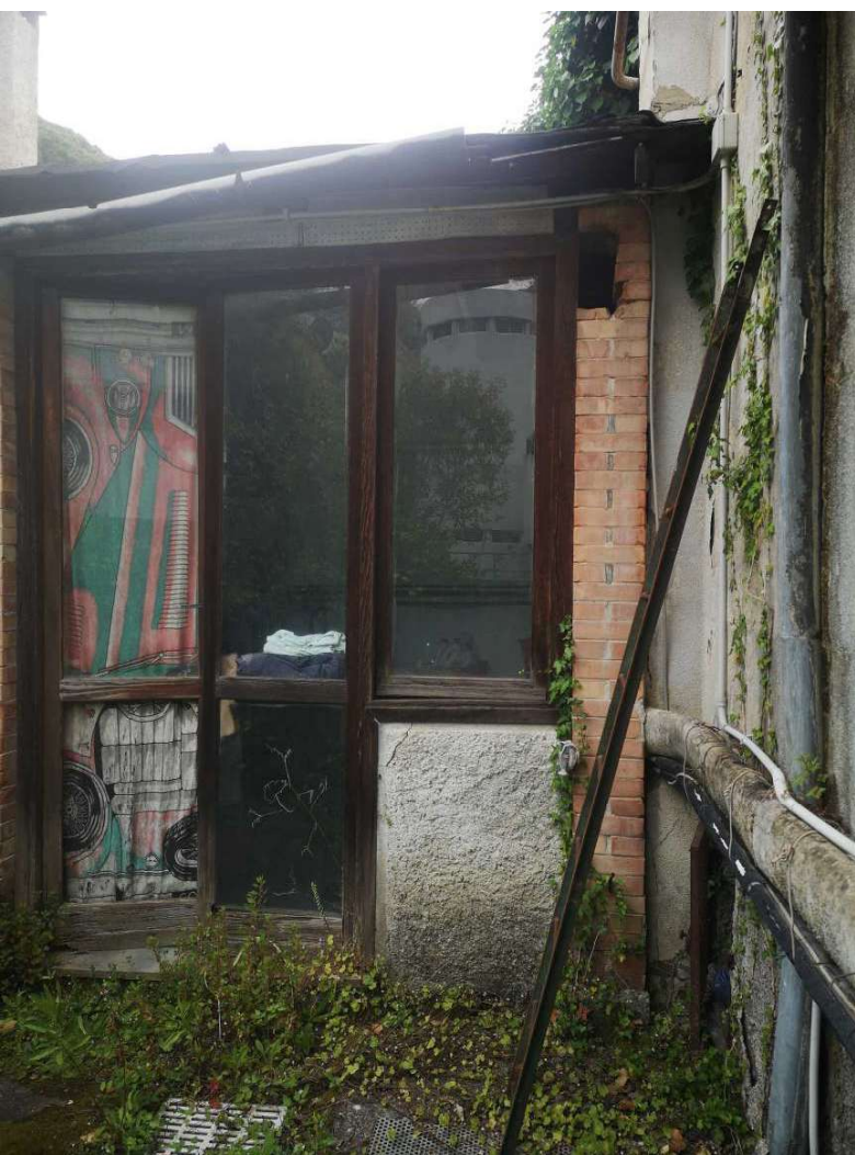
Accesso sud alla calderina
