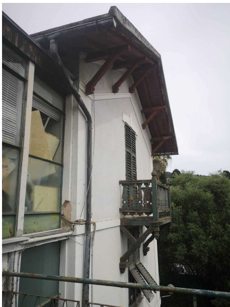
Prospetto est ripreso dal mappale 737
